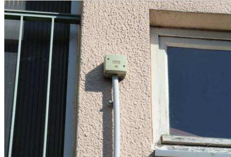
L'éclairage extérieur est assuré par des projecteurs, asservi à une sondes de luminosité pour ne se mettre en service que la nuit.
