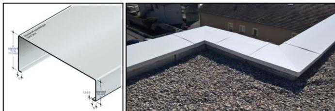
**La bande de rive en aluminium laqué** - Elle est utilisée pour l'arrêt de l'étanchéité en tête de l'acrotère au niveau de la façade. Elle permet d'assurer la protection du nez de dalle et d'éviter le passage d'eau derrière le revêtement de façade :
