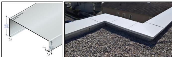
**La bavette** en aluminium laqué est un système permettant de protéger l'appui des fenêtres existantes et la partie haute du système d'isolation thermique par l'extérieure. La pente du support ainsi que le bord arrondi facilitent l'évacuation de l'eau. Le relevé de l'embout permet d'éviter les infiltrations et les coulures latérales. La retombée a pour fonction d'assurer une finition esthétique et une goutte d'eau pour limiter le ruissellement en façades.
