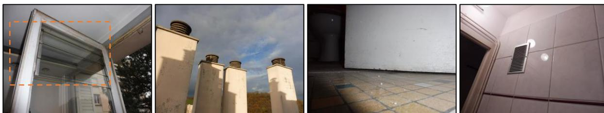
Ouverture dans vitrage d'origine / Conduits SHUNT en toiture / Porte non détalonnée / Grille de ventilation haute
